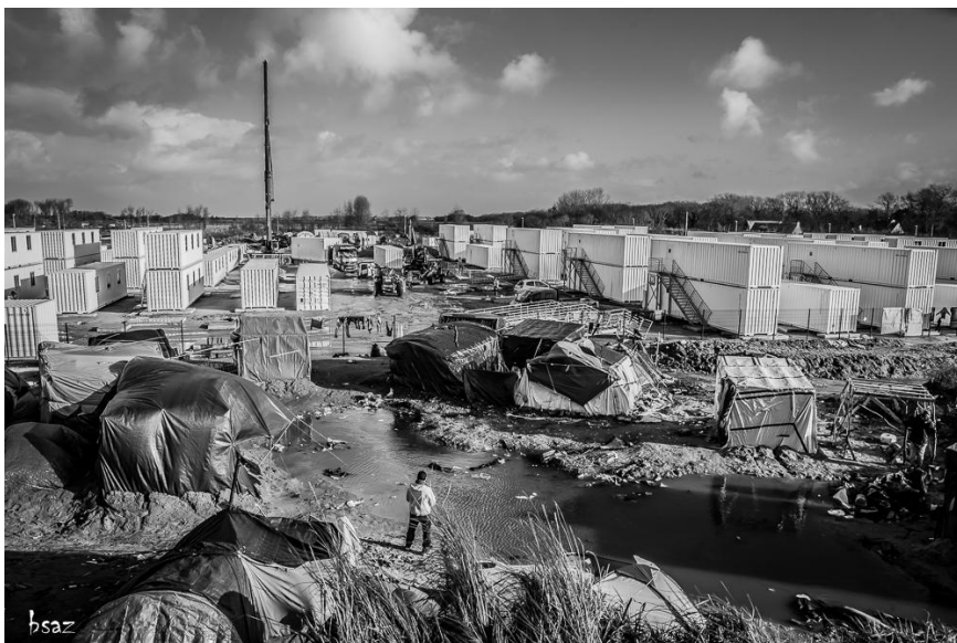
La New Jungle en construction © Blandine Sazenac.
